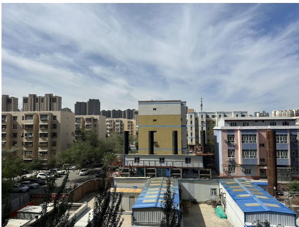
锅炉房现状图 1
