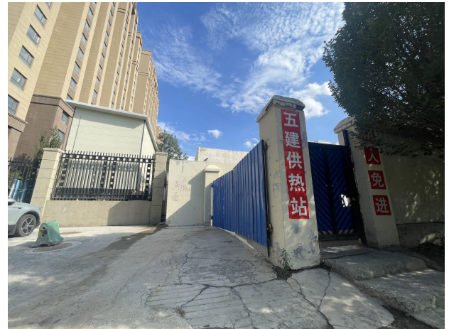
项目西侧为五建换热站
