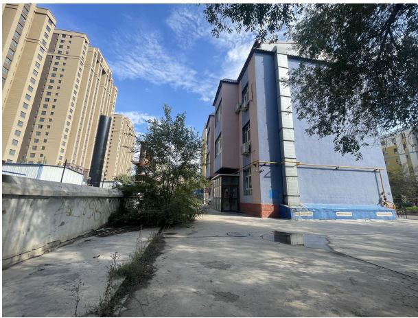
项目南侧为五建家属楼 1 号楼
