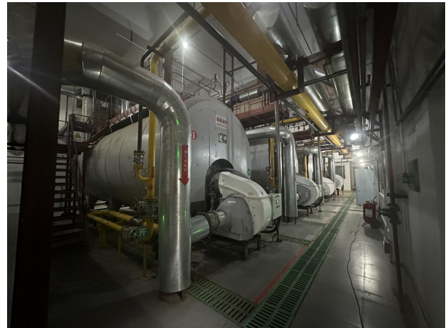
锅炉房现状图 2
