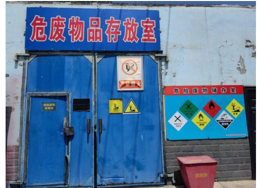
现有工程已建危废暂存间
