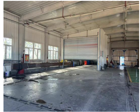
闲置车间现状（拟改造为1#喷漆房）
